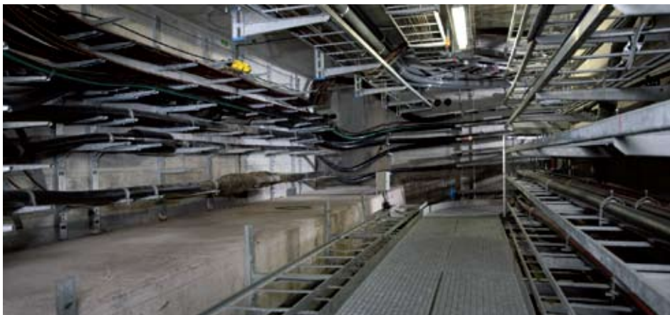
Figure 15 : Galerie technique, Genève (source : Services Industriels de Genève)
